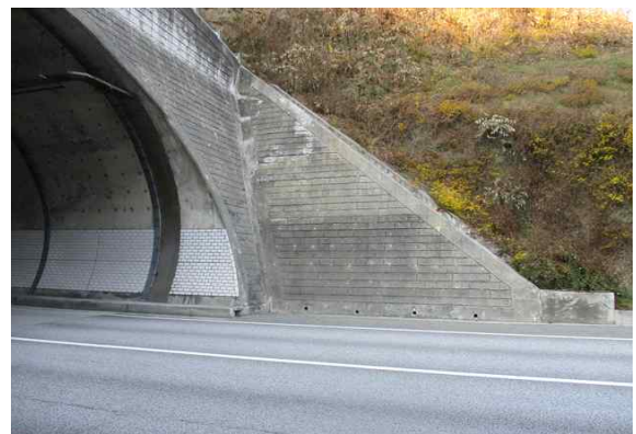
종점부 옹벽 상태양호
