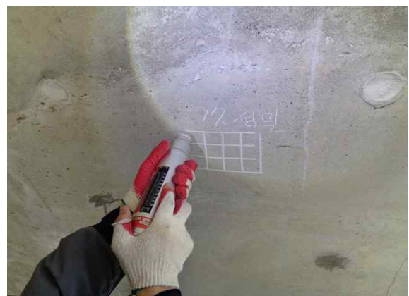
반발경도 측정 현황(측벽부)
