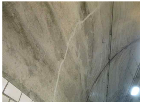
라이닝 SPAN.92 측벽부 균열 보수현황
