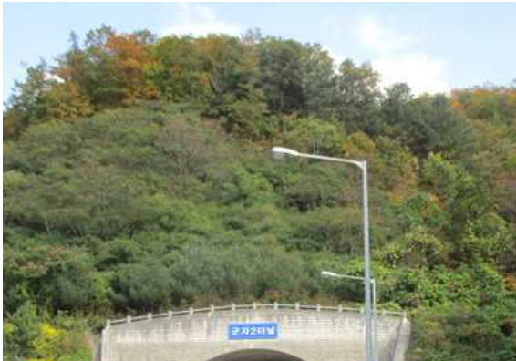
시점부 사면 전경
