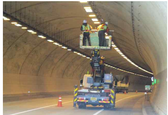
고소작업차를 이용한 외관조사 현황①
