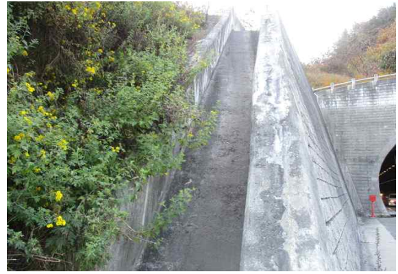
종점부 도수로 전경
