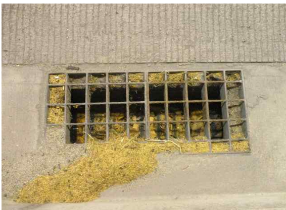
배수시설 집수구 전경
