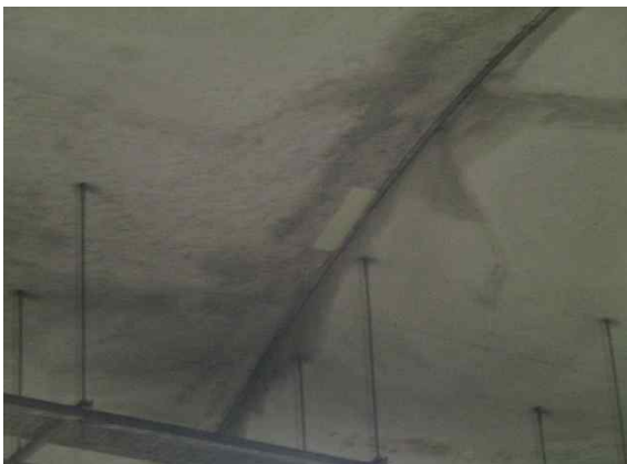
라이닝 SPAN.84 조인트부 박리 보수현황
