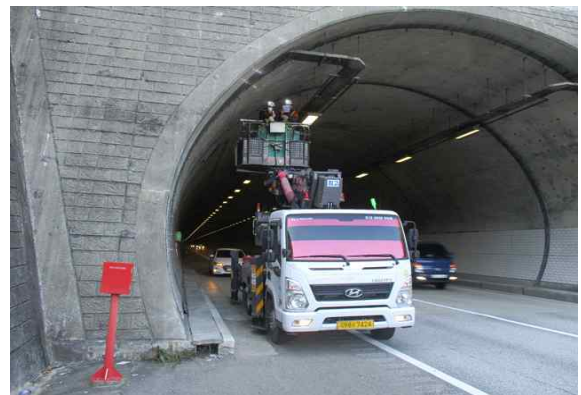
고소작업차를 이용한 외관조사 현황③
