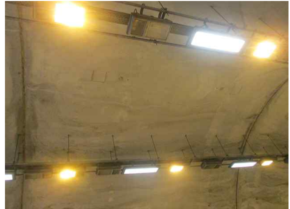
라이닝 SPAN.41 천단부 균열 보수현황
