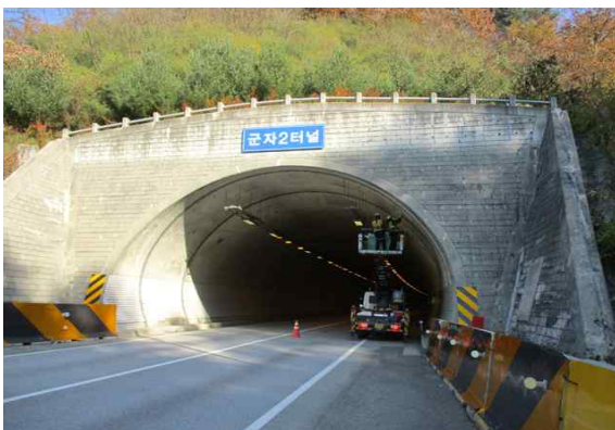
시점부 옹벽 전경
