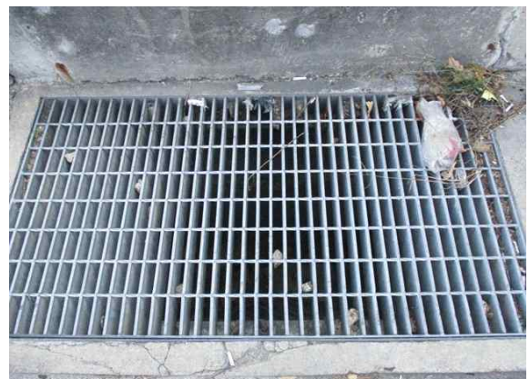
배수시설 집수구 상태양호
