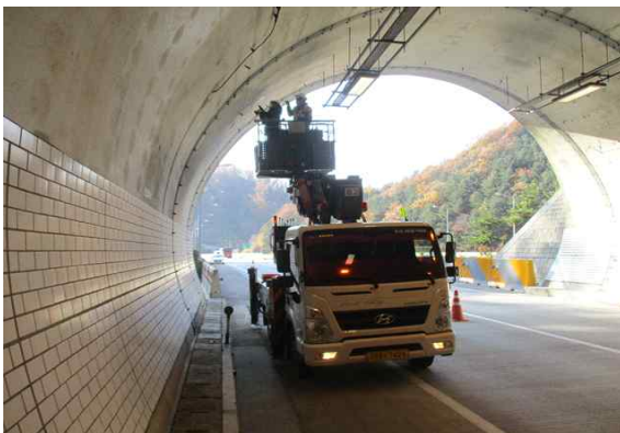
고소작업차를 이용한 외관조사 현황②
